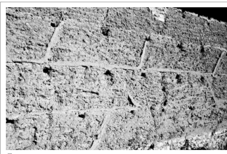
Mur de clôture en pisé avec joints à l'équillade monté sur un soubassement en appareillage de pierres.
